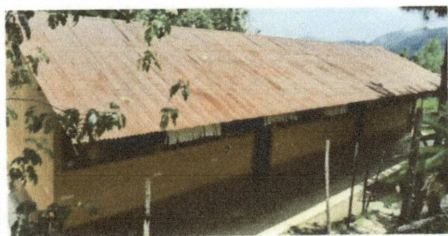
Foto 3: Rehabilitación de canal pluvial y bajada de agua (modulo 2) 23.45x9.95 mts.
