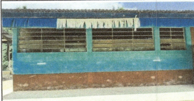
Foto 6: Vidrios quebrados que necesitan ser sustituidos por nuevos (modulo 1)
